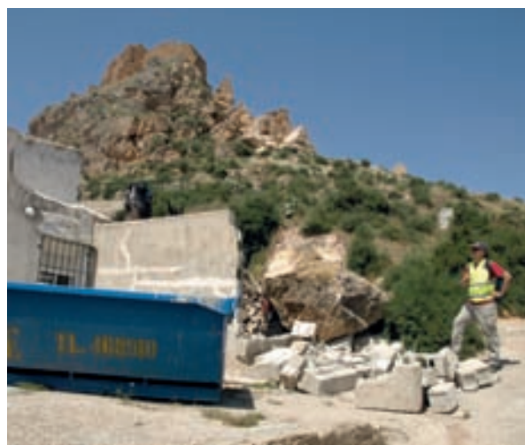
Figura 7. Caída de bloques en la ladera sureste del castillo de Lorca afectando a casas de la localidad.
