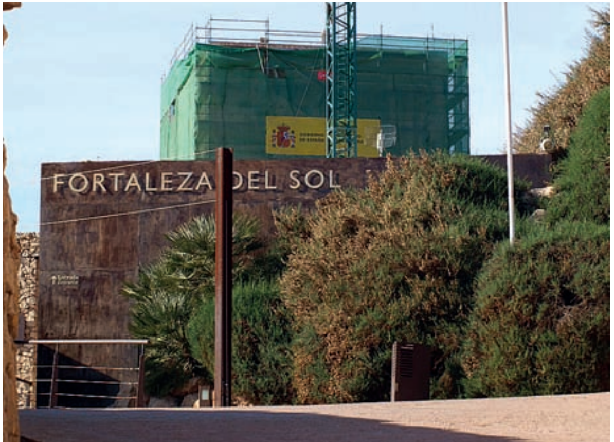
Trabajos de consolidación y restauración de la torre del Espolón del castillo de Lorca. Fotografía: Lorca Taller del Tiempo.
