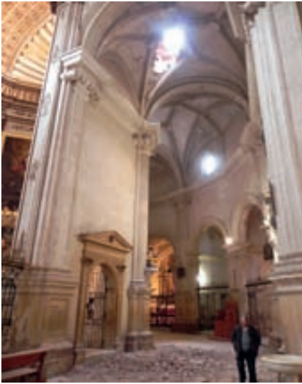
Fotografía 14. Izquierda. Interior de la iglesia de San Patricio tras el terremoto. Se observa uno de los agujeros en las cubiertas y bóvedas provocados por la caída de los pináculos de la torre.
