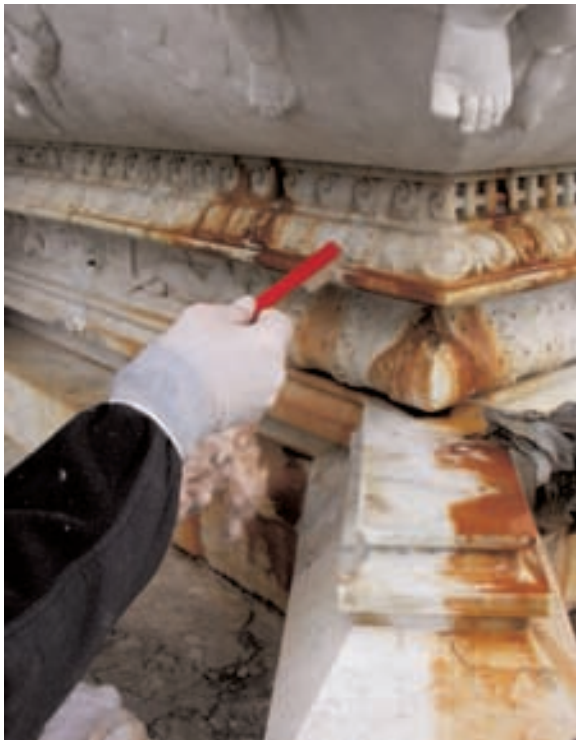
Detalle de la limpieza mecánica. Fotografía: In Situ, S.L.
