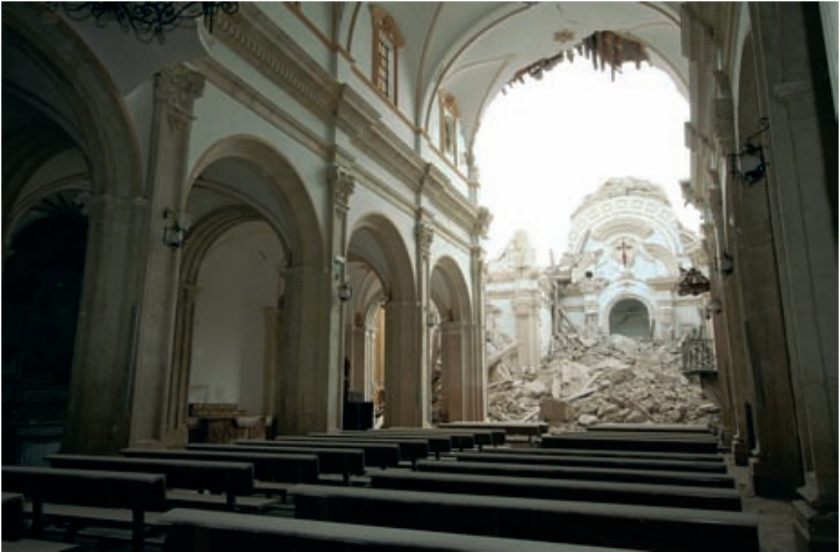
Iglesia parroquial de Santiago Apóstol de Lorca. Mejorar el control de las intervenciones sobre inmuebles, en relación a la compatibilidad del comportamiento de las estructuras frente a terremotos, es uno de los aspectos más necesarios. Fotografía: Concha Cirujano.
