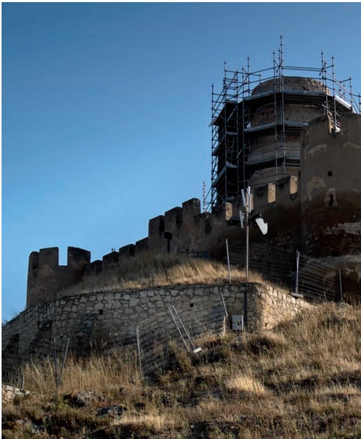
Restauración del castillo de Biar, Alicante. Proyecto realizado por el IPCE (2009-2010). Fotografía: Jesús Herrero. IPCE.
