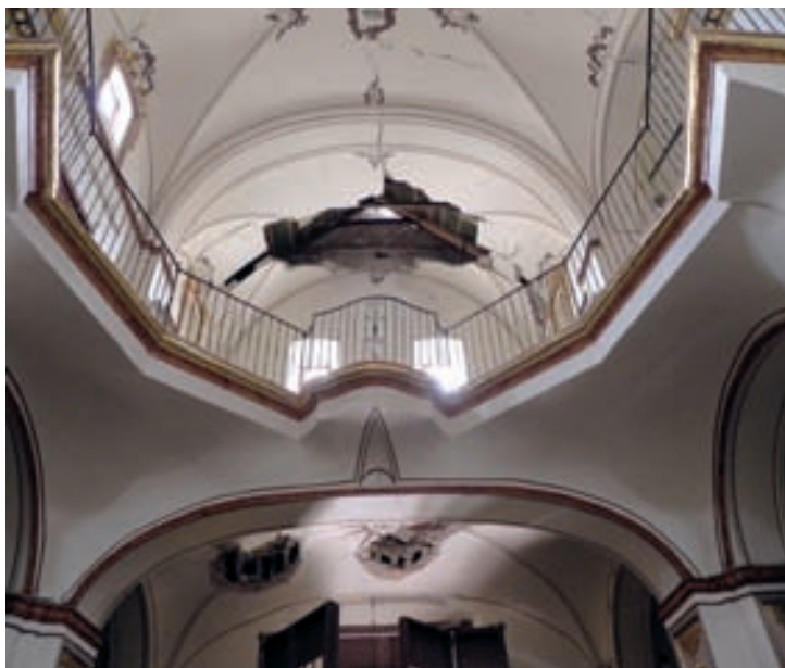
Fotografía 12. Izquierda. Desplome de parte de la bóveda sobre el coro en la iglesia de El Carmen y rotura del forjado y bóveda del propio coro.
