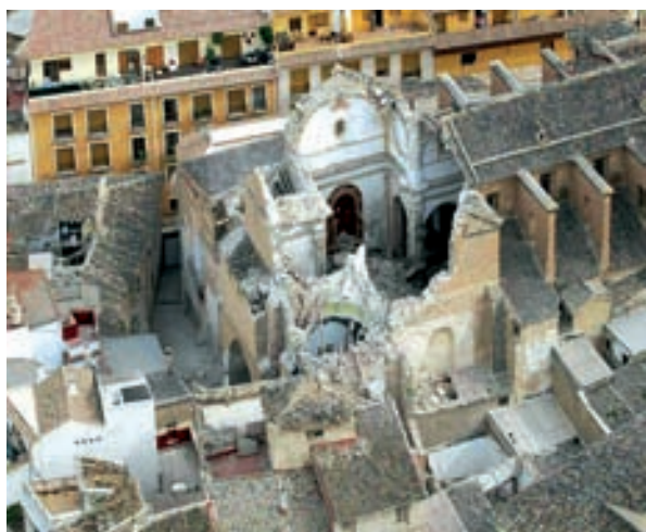
Iglesia de Santiago tras el terremoto.
