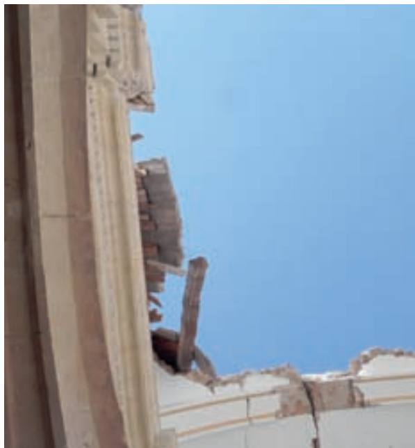
Fotografía 8. Detalle de la cubierta de la iglesia de Santiago, con una losa de hormigón armado sobre la estructura de madera.
