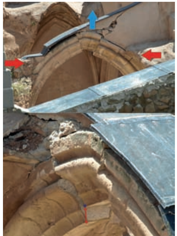
Figura 14. Clave extruida en la iglesia de Santa María (Lorca) como consecuencia del terremoto del 11 de mayo de 2011.
