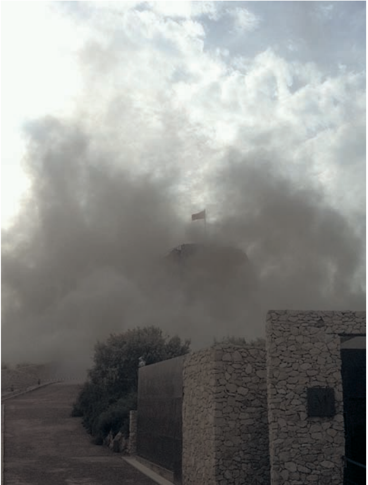
Momento del desplome de la parte superior de la torre del Espolón durante el segundo terremoto de mayo de 2011. Fotografía: M. a de los Ángeles Lirón.
