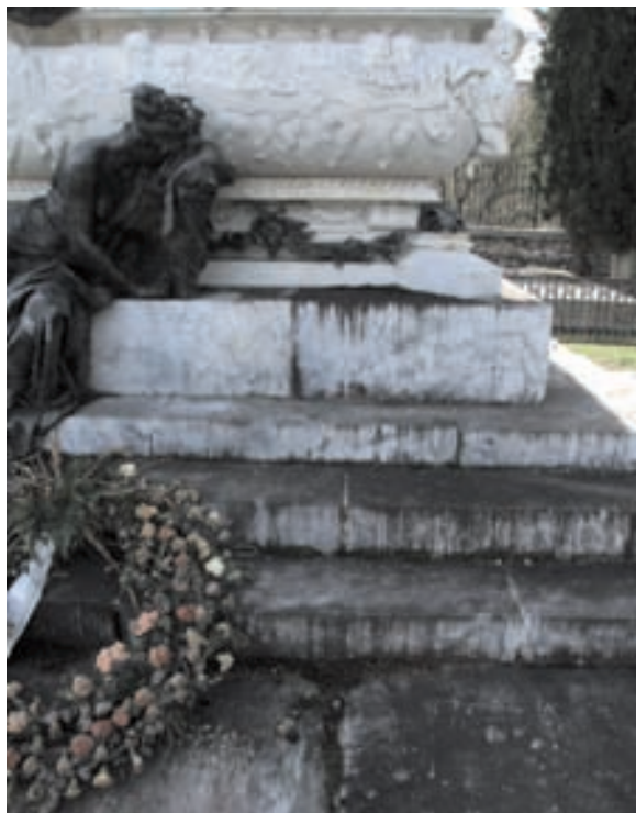
Contaminación biológica de la zona norte. Fotografía: In Situ, S.L.
