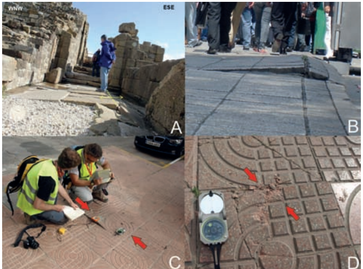
Figura 9. Pliegues asimétricos en: a) enlosado del teatro de la ciudad romana de Baelo Claudia (Cádiz, España); b) enlosado de la acera de la calle Dolores en su confluencia con Independencia en México DF, estos pliegues fueron generados por el devastador terremoto de Michoacán de 1985; c) y d) enlosados plegados y con marcas de impacto en la localidad de Lorca, generados por el terremoto del 11 de mayo de 2011.
