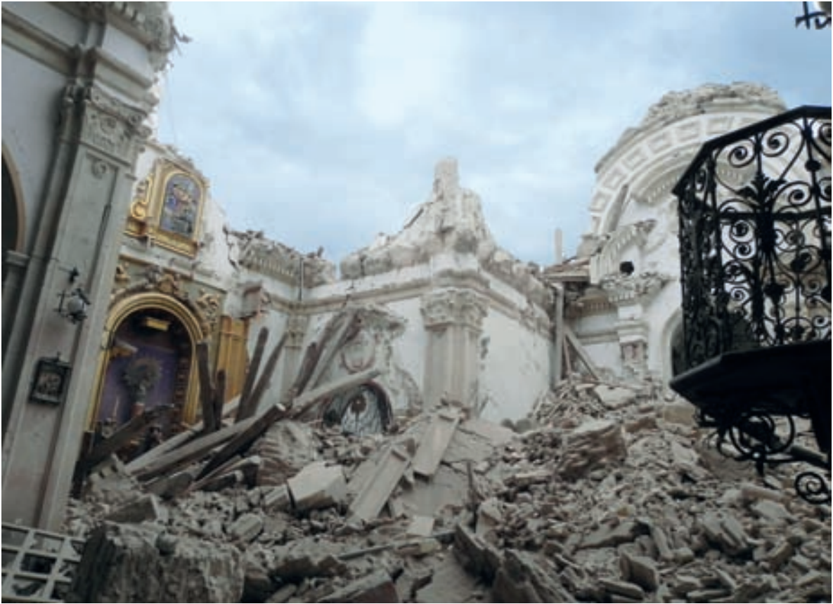
Fotografía 7. Interior de la iglesia de Santiago el día 12 de mayo, con el desplome completo del crucero y cúpula.
