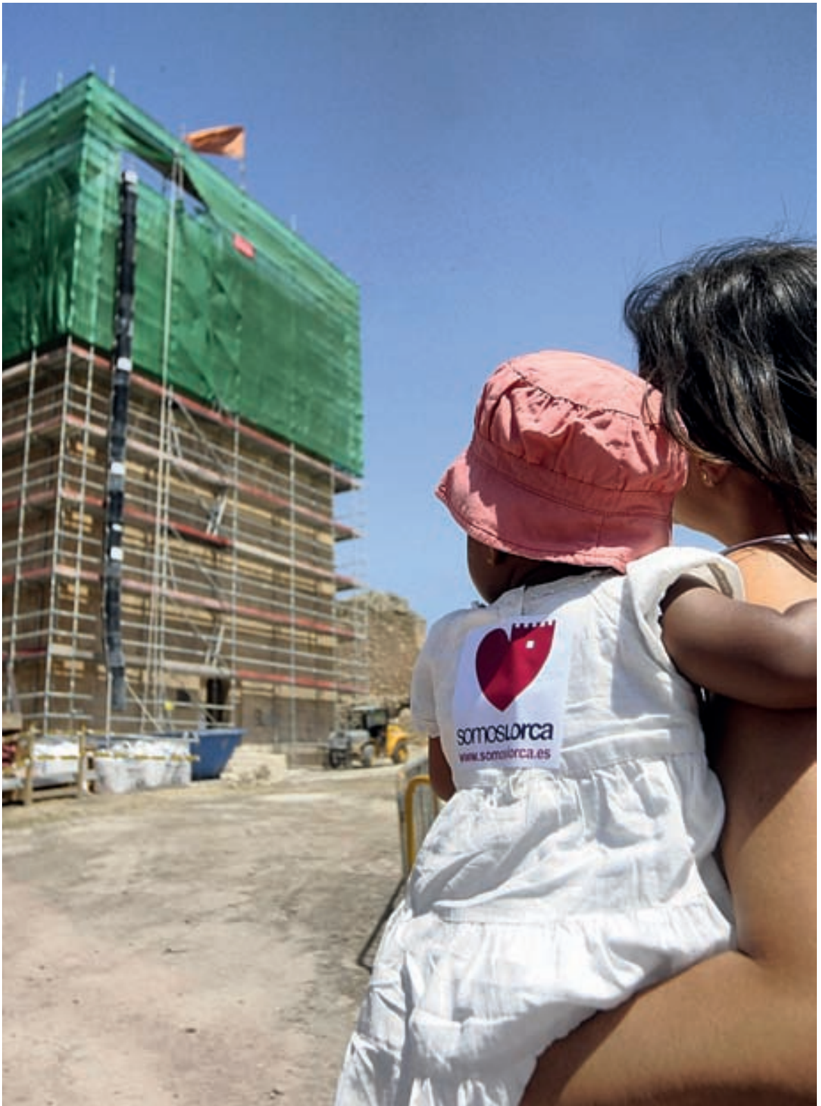
Trabajos de restauración en la torre del Espolón de Lorca. Fotografía: Israel Sánchez.
