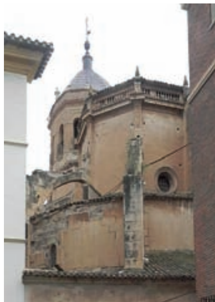
Fotografía 12. Izquierda. Desplome de parte de la bóveda sobre el coro en la iglesia de El Carmen y rotura del forjado y bóveda del propio coro.
