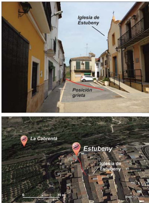
Fig. 24. Localización de las principales grietas en la población de Estubeny descritas en la documentación de la época (Félix Carrasco, 1748, Sarthis, 1922).
