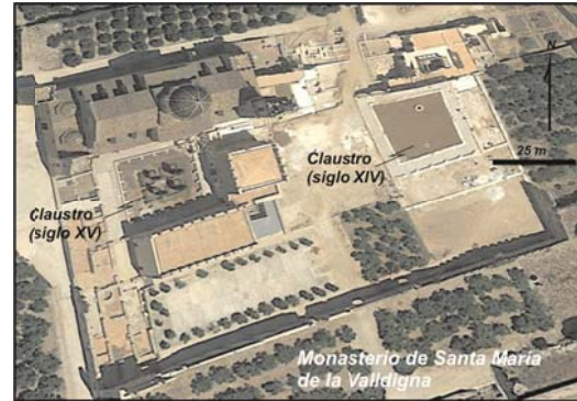
Fig. 44. Imagen de la planta actual del Monasterio de Santa María de la Valldigna en el que se observa el claustro del siglo XIV destruido por el terremoto de 1396, y su reconstrucción unos 50 metros al oeste (siglo XV). Este segundo claustro fue destruido por el terremoto de 1644 al igual que la iglesia del monasterio (Imagen de google earth).
